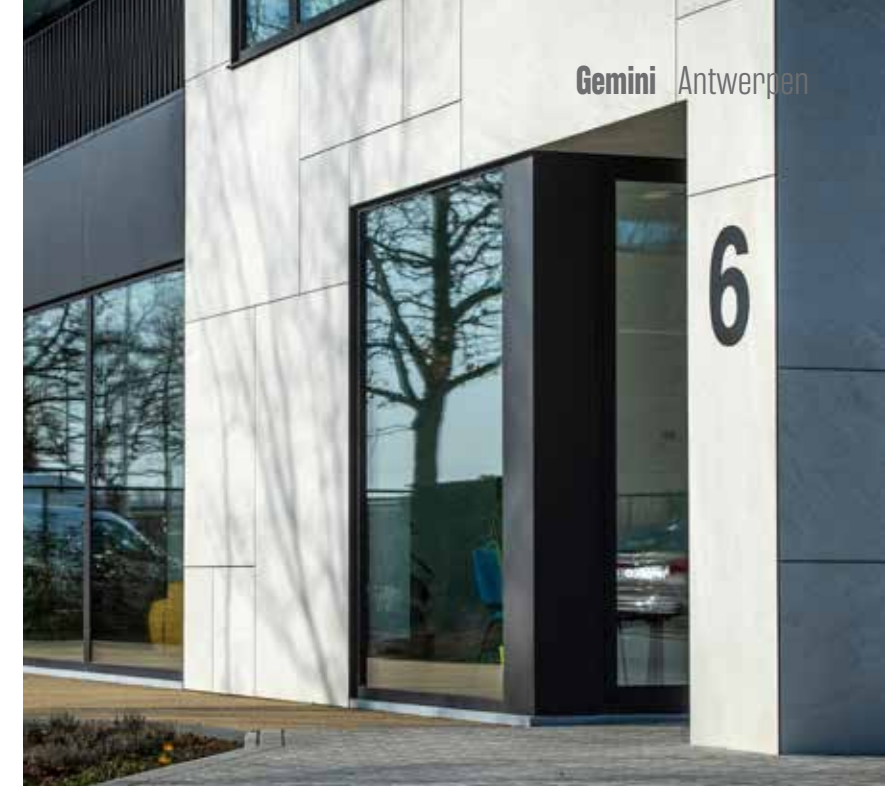
De gevelbekleding van het nieuwe Gemini-gebouw bestaat uit in wildverband aangebrachte keramische tegels met een formaat tot 2,4 op 1,2 meter.
