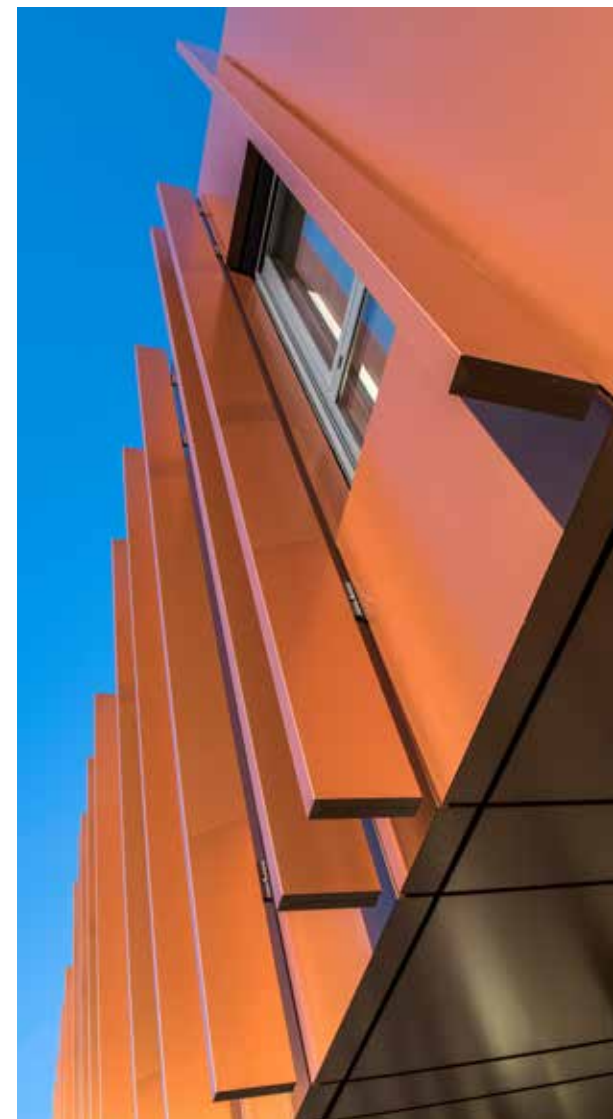
Ook Arpal koos voor de composiet gevelcassettes van Limeparts.
