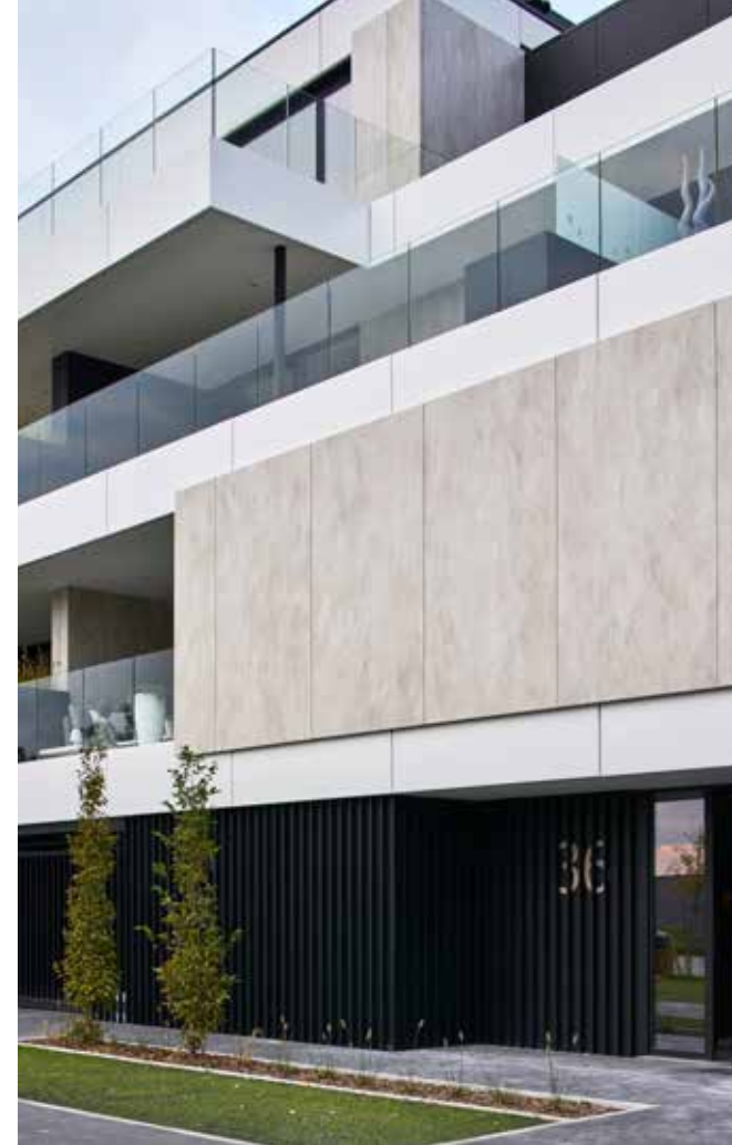
De dichte gevelvlakken zijn bekleed met een stijlvolle schakering van witte en zwarte aluminium cassettes, afgewisseld met zandkleurige keramische grootformaattegels.
