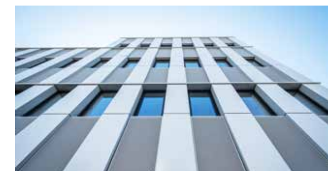
Ook op het nieuw Administratief Centrum in Luik drukte Limeparts-Drooghmans zijn stempel.
