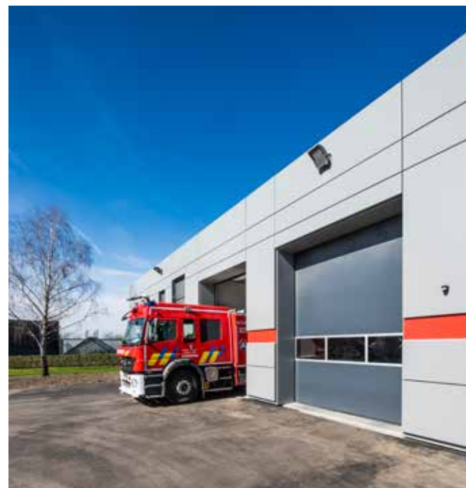
In elk gebouw is een rode band verwerkt die verwijst naar de brandweer.
