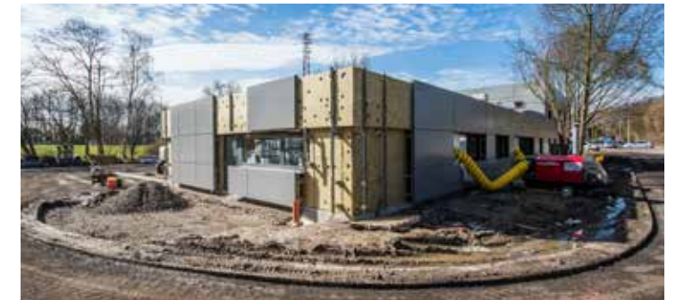
Elk paneel is individueel uitneembaar en het bevestigingssysteem is onzichtbaar.
