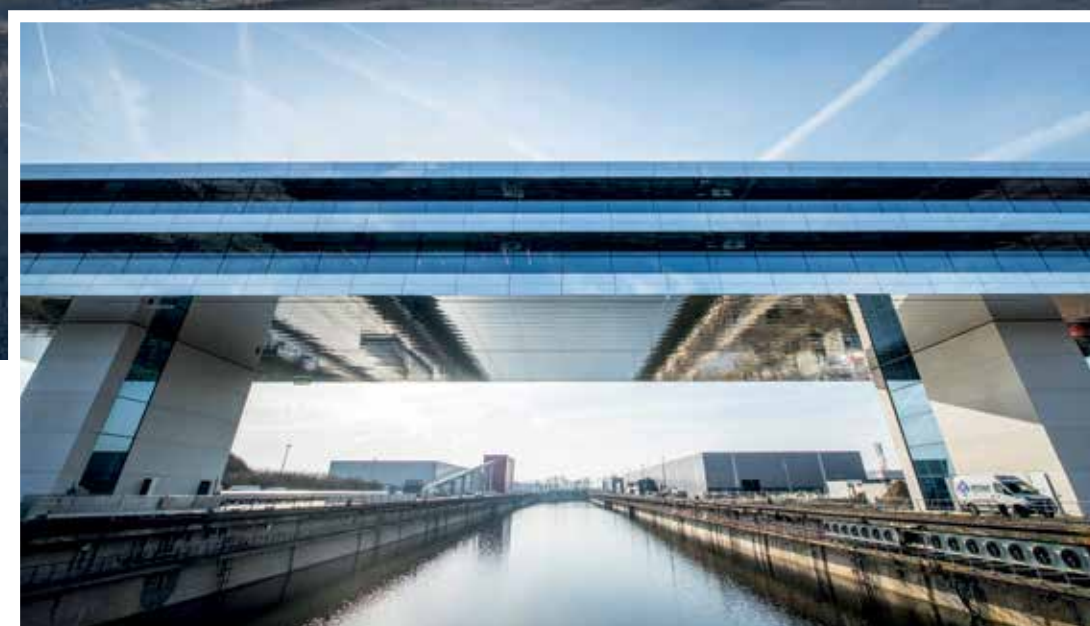
Gezien de specifieke ligging op het voormalige droogdok was het plaatsen van de gevelpanelen geen sinecure.
