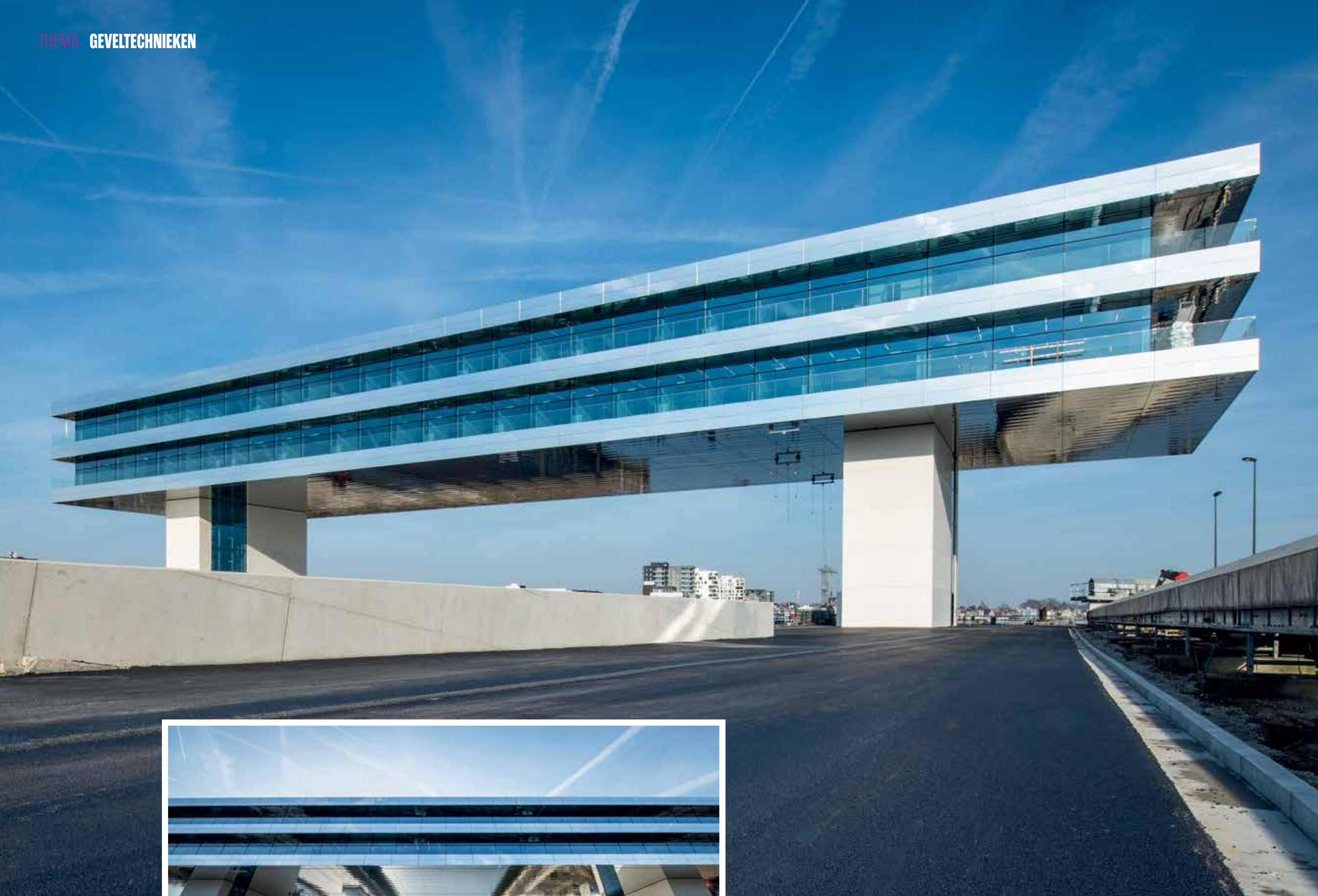
In totaal zijn er 5.500 m 2 Alucobond-panelen geplaatst.
